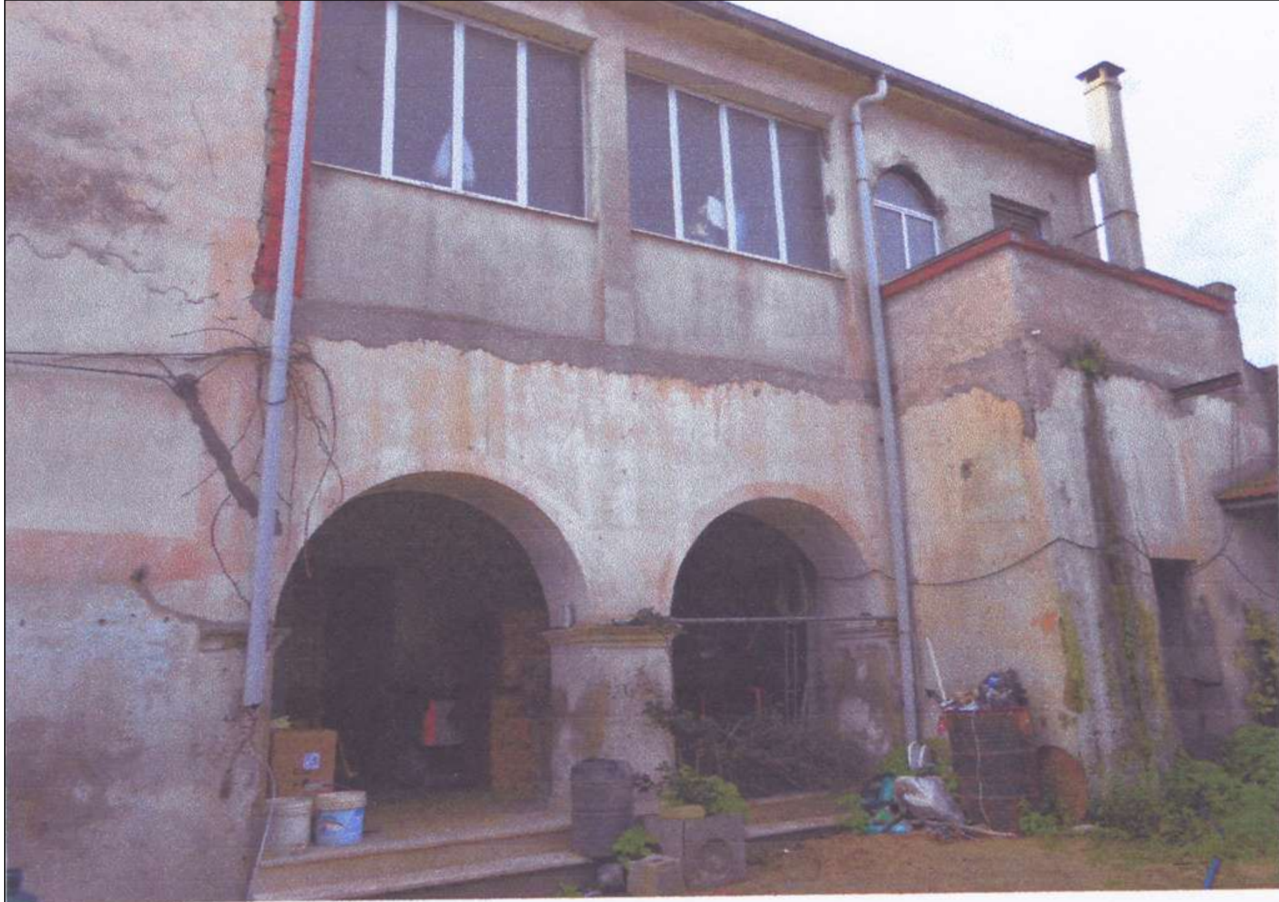
Veduta facciata interna
