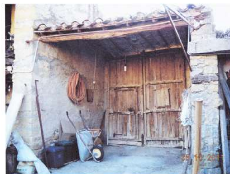
VISTA PORTALE DA RISTRUTTURARE DAL CORTILE INTERNO
