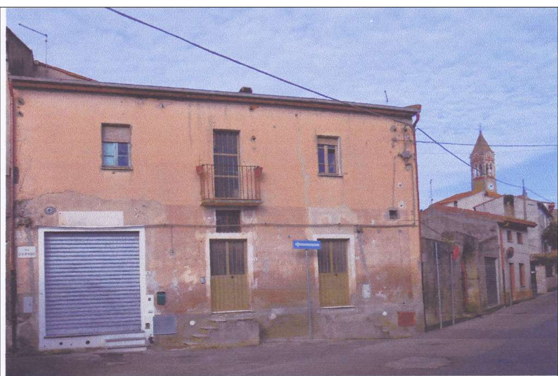
Veduta prospetto esterno incrocio Via G.B. Tuveri e Via E. D'Arborea
