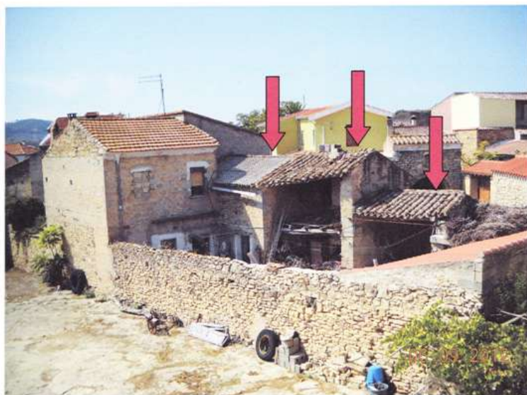
VISTA D'INSIEME FABBRICATI ACCESSORI OGGETTO D'INTERVENTO DAL CORTILE
