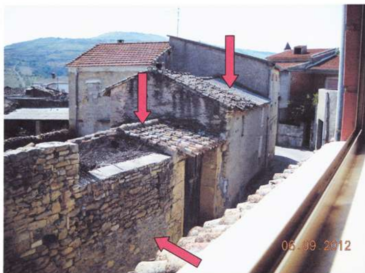
VISTA D'INSIEME FABBRICATI ACCESSORI OGGETTO D'INTERVENTO DA VIA UMBERTO
