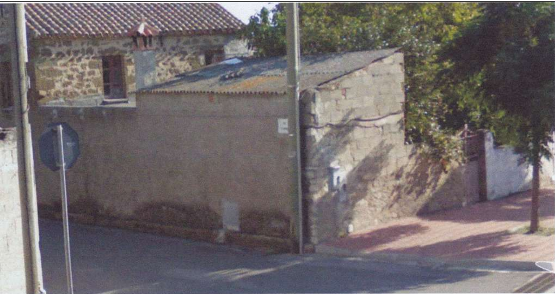
Figura 1: VISTA DALL'EDIFICIO DALLA VIA NAZIONALE ANTERIORE DELL'IMMOBILE OGGETTO DI INTERVENTI.
