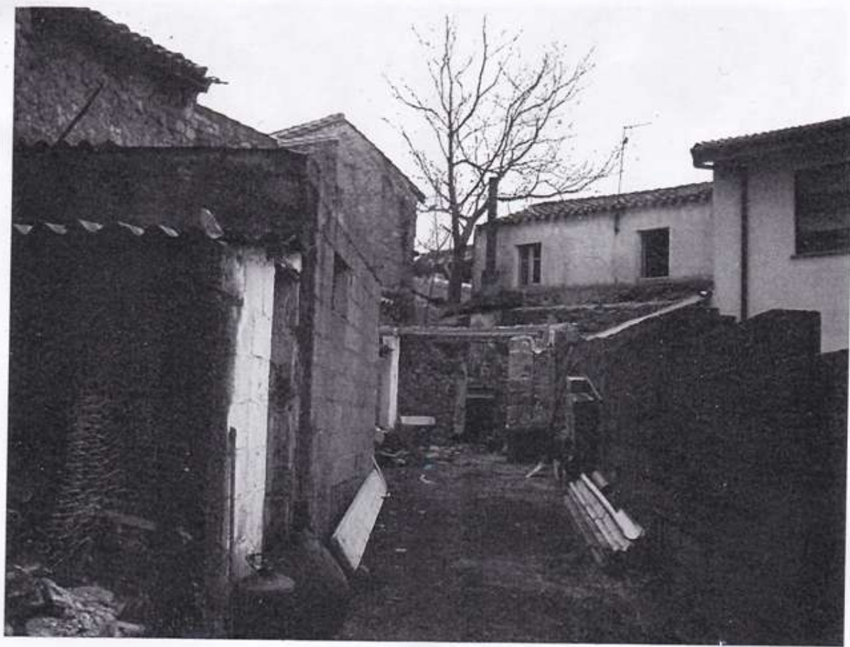
Fot. n. 1 – Vista prospetto principale
