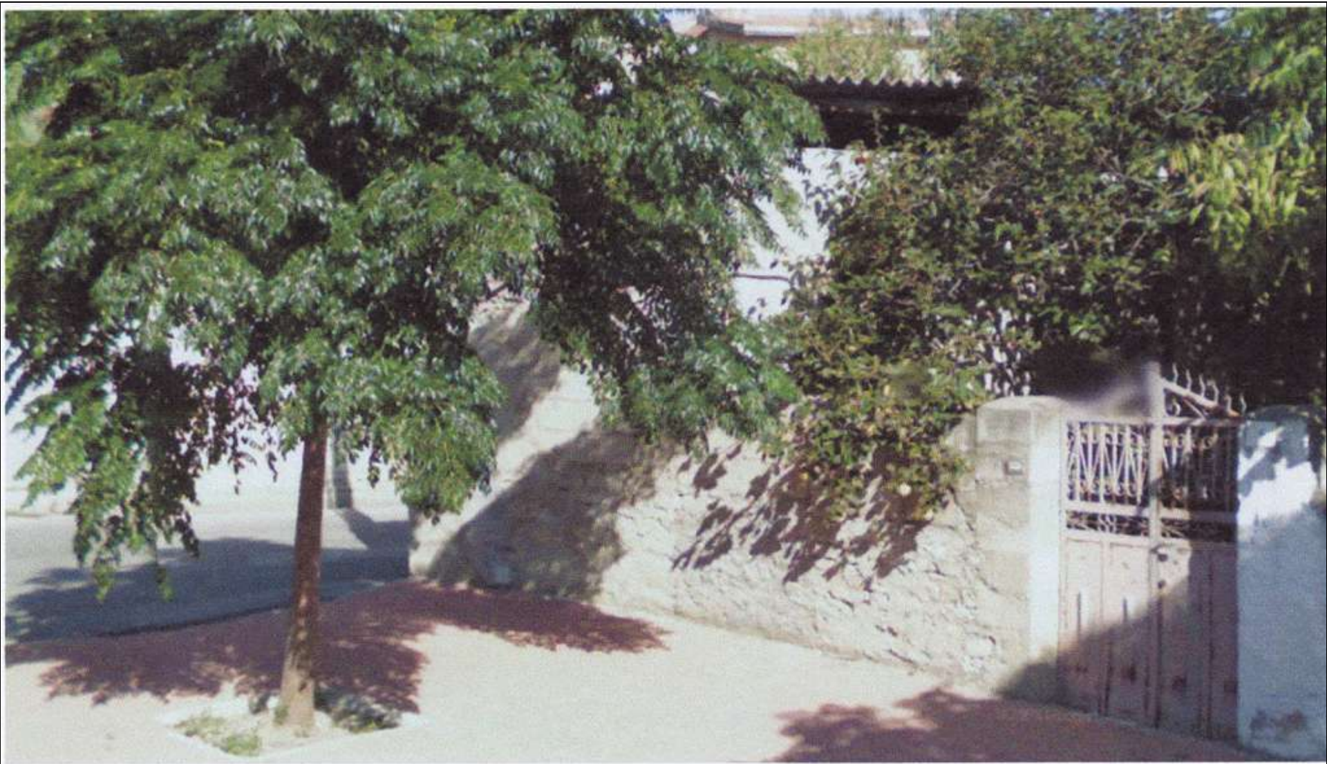
Figura 2: dettaglio muratura in pietra.
