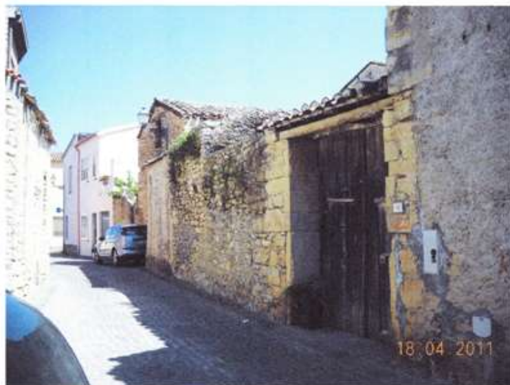
VISTA PORTALE E PROSPETTO DA RIQUALIFICARE VIA UMBERTO
